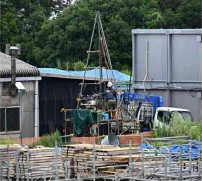
自衛隊宿舎の建設地付近で行われているボーリング調査 —18日、西之表市西之表
